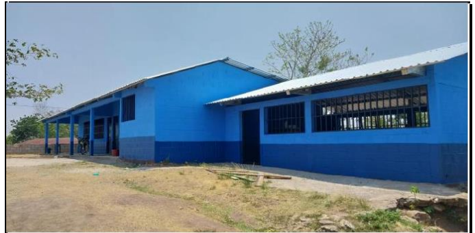
Foto 4: Lamina troqueladas calibre 26 instaladas
