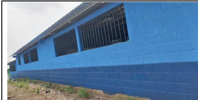
Foto 1: balcones instaladas en la parte exterior.
