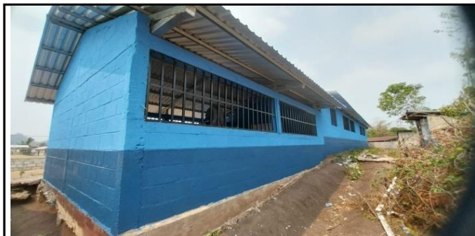
Foto 5: pintura en muros interior y exterior.
