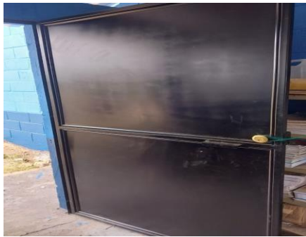
Foto 3: puertas instaladas según priorizadas
