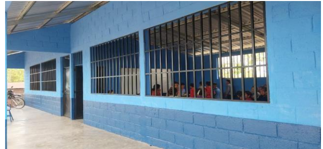
Foto 2: balcones instaladas en la parte interior.
